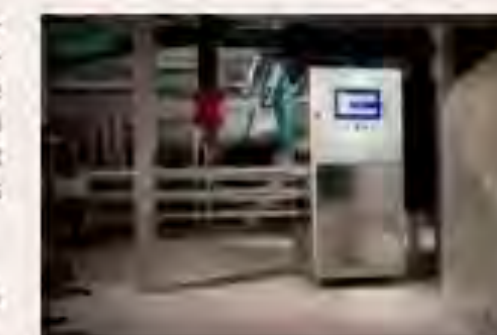
Et centralt anlæg nedbryder lattergas med varme til nitrogen og oxygen. (rumluft) Det bilattes AGSS vakuumsystemet som opsamlers gassen fra op til 16 patientstuer.
